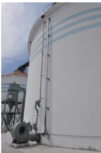
浅圆仓内环流控温储粮技术
